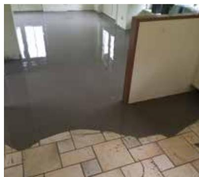
(1) Avec une pose de parquet, la déviation permise du niveau est de 2 mm sur une longueur de 1 m et 3 mm sur une longueur de 2 m.
